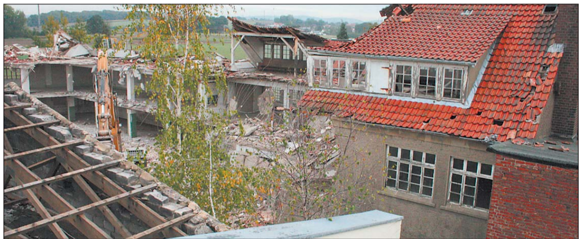
Sechs bis acht Wochen soll der Abriss des Gebäudes | Bau von Bungalows geplant. Zuvor war das Gebäude von ICI Pretechnik dauern. Nach dem Winter ist der | 20 Jahre ungenutzt. Fotos: Annika von Hollen
