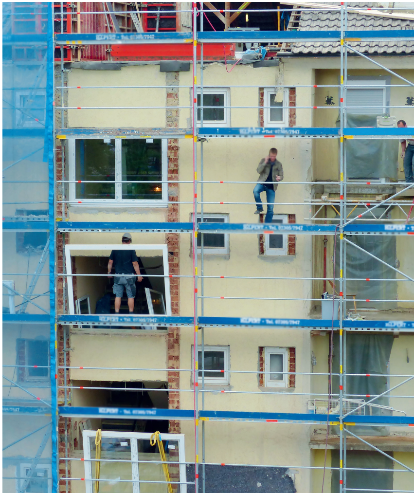
Neue Fenster im Mietobjekt
