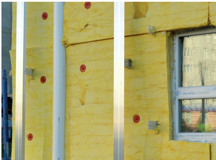
Wärmedämmung der Fassade
