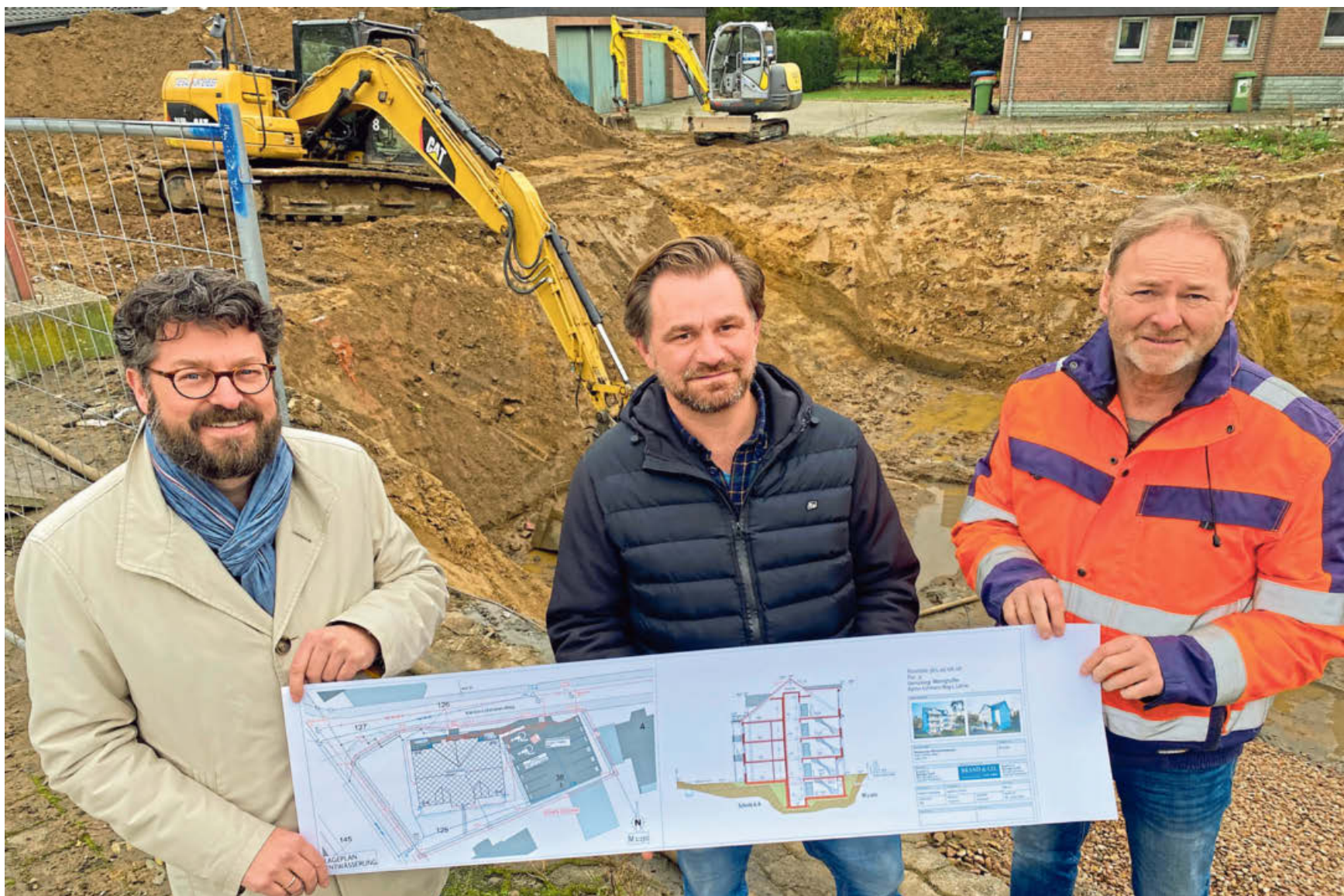
Frank Viseneber (v. l.), Adriano Maniscalco, Detlef Kuntemeier vom gleichnamigen Tiefbauunternehmen an der Baustelle. Hier soll das neue Haus entstehen. Foto: Dirk Windmüller
