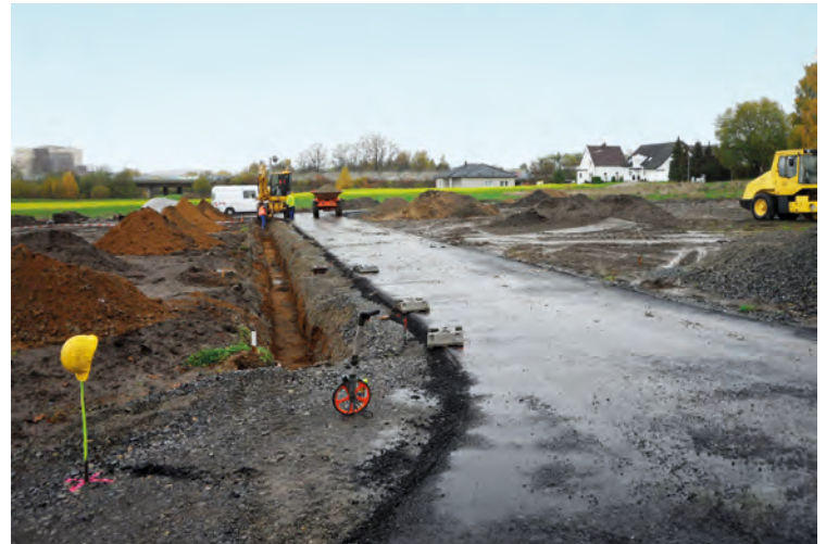
Versorgungsbau im Baugebiet „In der Aue“
